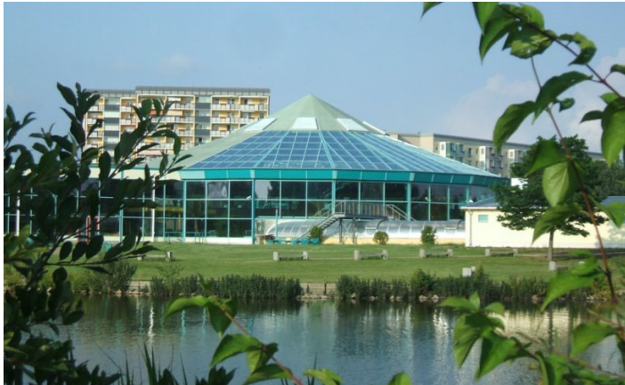
Erweiterung Lausitzbad Hoyerswerda
