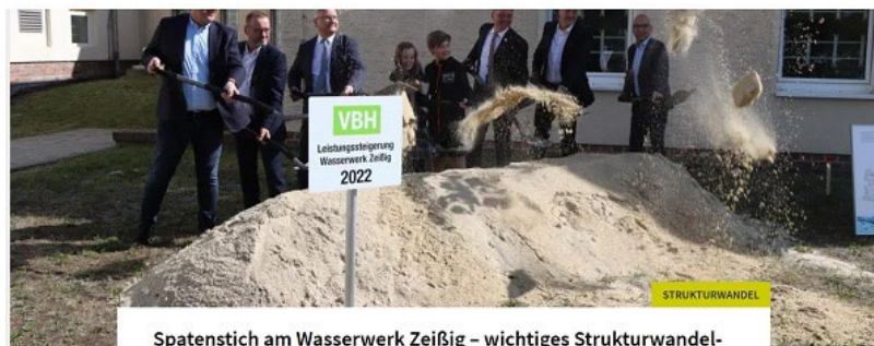
Spatenstich am Wasserwerk Zeißig – wichtiges Strukturwandel-Projekt geht in die Umsetzung #WHY
