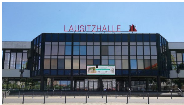
Hoyerswerda: Energetische Sanierung der Lausitzhalle
